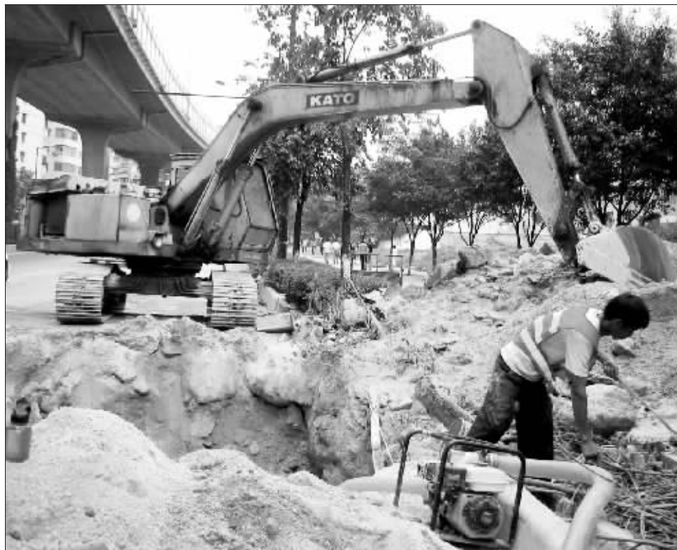
工作人员正加班加点,争取尽快将冲坏的排水管及路面修复完毕。时报记者 朱元斌 摄
