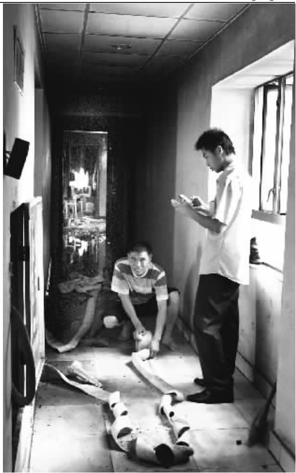
一工作人员正在整理消防水管,空气中弥漫着一股焦糊味。 时报记者 杜翠 摄
