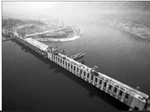
▶三峡大坝航拍图。三峡大坝坝轴线全长2309米,是世界最长的大坝。新华社发
