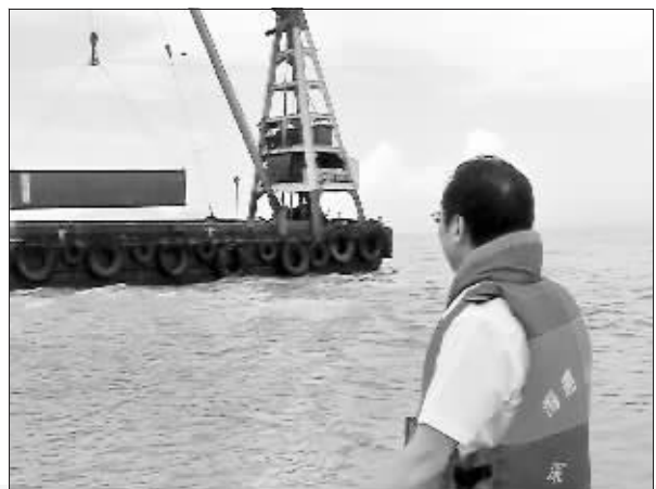
▲昨日11:15,首只集装箱被成功吊起。通讯员 欧阳可华 摄
