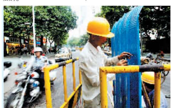
昨日,工人们正在进行道路障碍物安装的工作。
