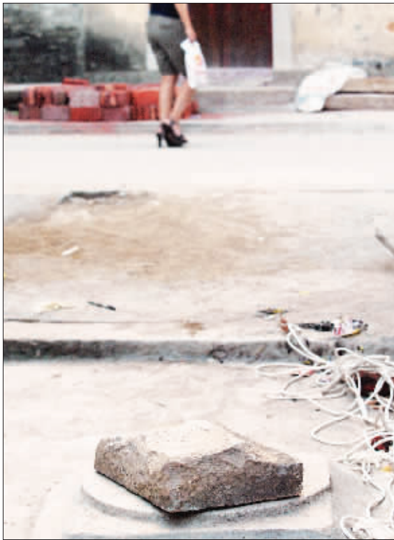
出事井口已被一块石头盖住。据介绍，事发前，田兴维的丈夫怕她做傻事，也曾用石头盖住井口。
