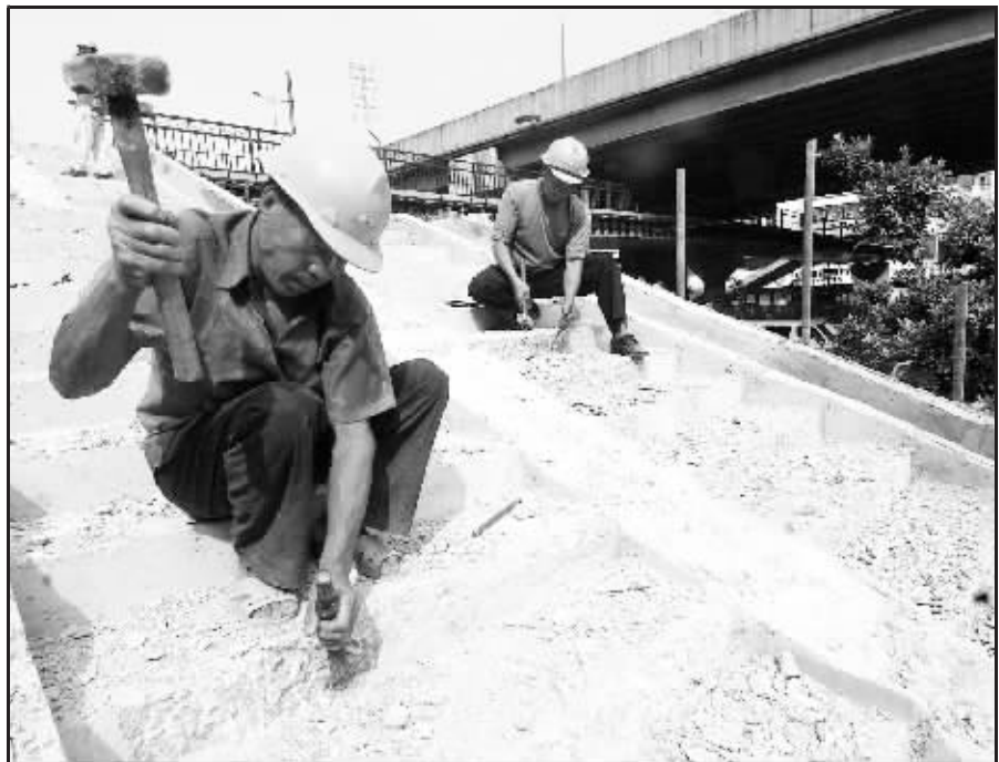
工人正在人行天桥紧张施工。时报记者 何建 摄
