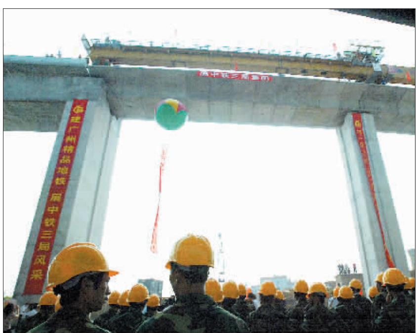
地铁四号线低涌—黄阁段高架桥顺利合龙现场。时报记者 杜翠 摄
