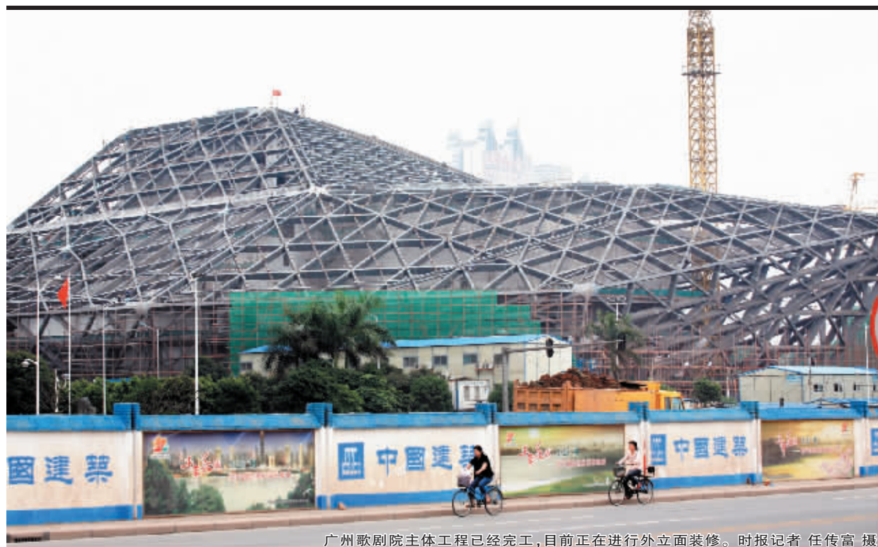
广州歌剧院主体工程已经完工,目前正在进行外立面装修。时报记者 任传富 摄
