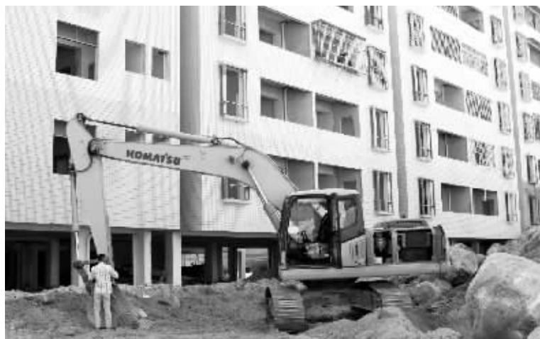
宅基地改建商品房住宅正在装修中。
