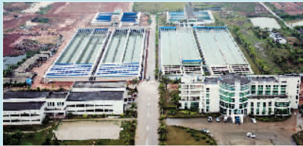
今年 4 月份江北水厂二期工程已经竣工并投入生产,目前市区供水能力已达到每天 70 万吨(惠州市自来水总公司供图)
