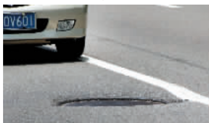
机场路一下沉井坑远看隐秘不少车中招
