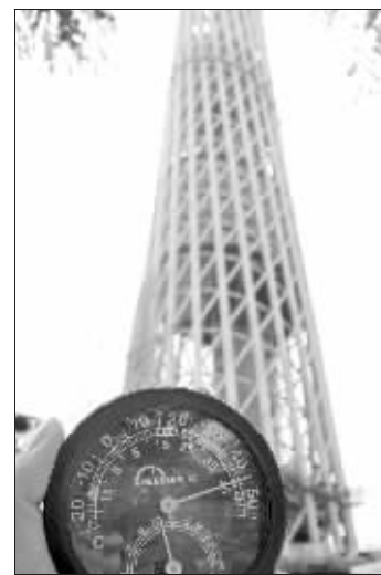
新电视塔工地温度达到45℃。
