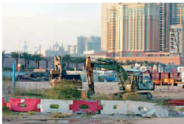
澳门金沙扩建工程工地。
