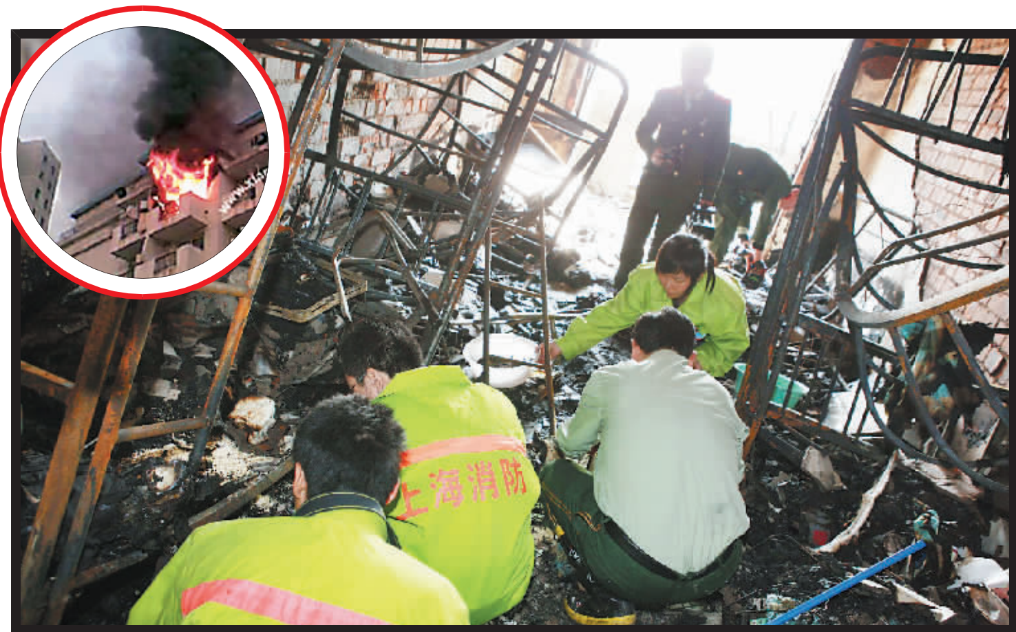
20平方米大的房间内已经成为一片废墟。8个床位的双层床铺被烧得只剩下铁骨架,阳台上的玻璃门窗也已经完全爆裂,原本粉刷一新的墙面上露出了大片的红色砖墙。 新华社发
