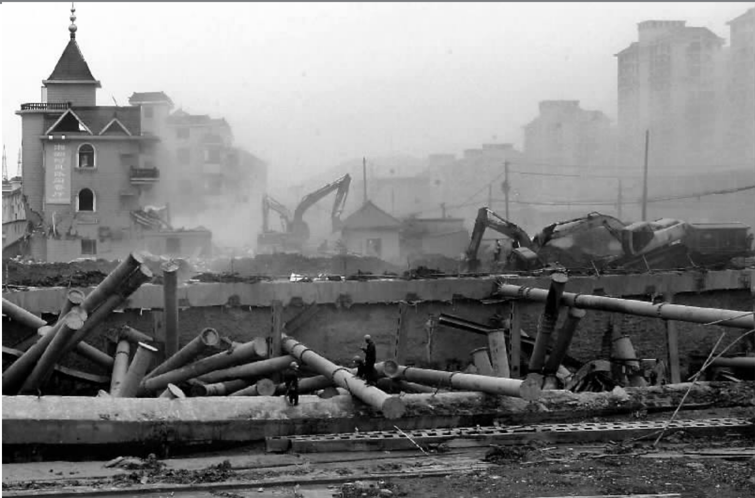
大型挖掘机器在清理塌方的地铁工地两边的危房和泥土。
