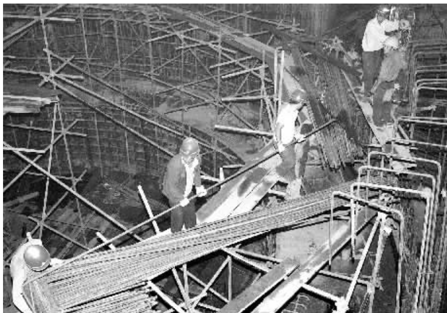
“西电东送”重点工程贵州索风营水电站的建设者在施工。新华社发
