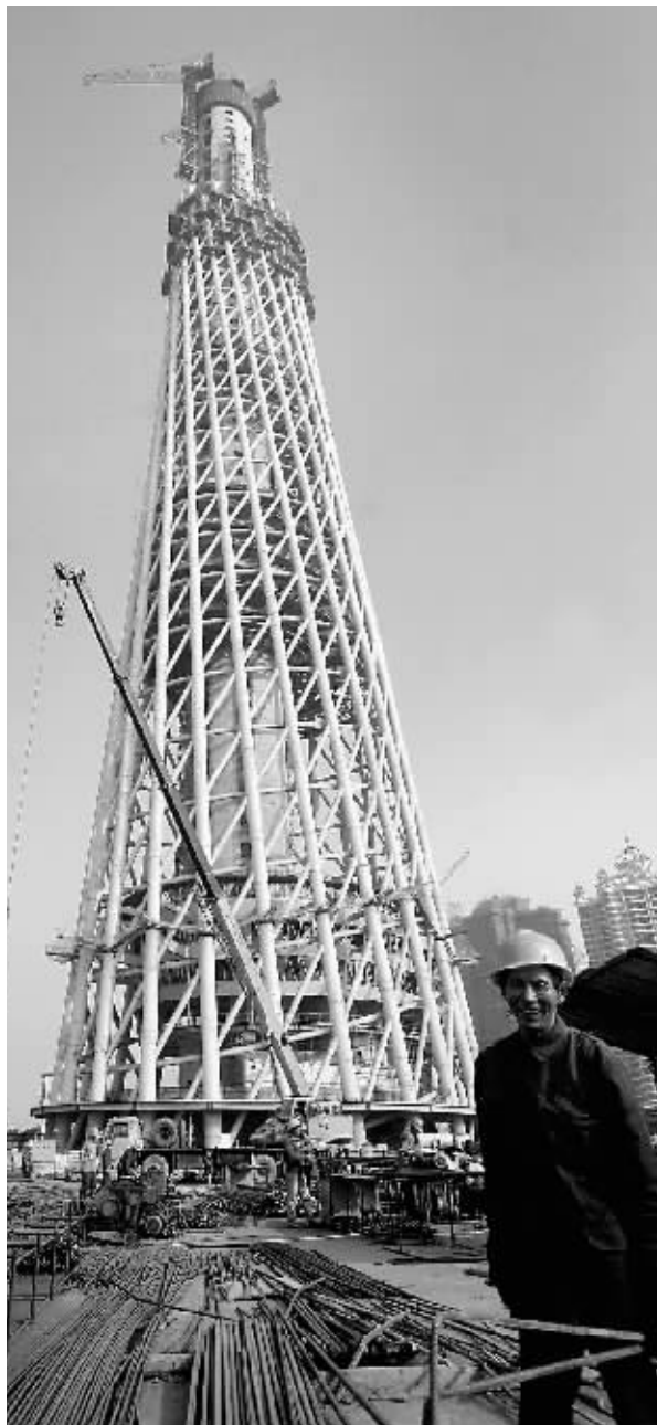
广州电视塔正在安装的高空玻璃幕墙具备防弹的功能。 信息时报记者 郭柯堂 摄
