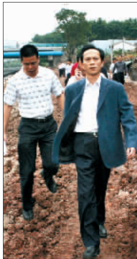
荔湾区区长周亚伟深入施工现场检查指导工作。
