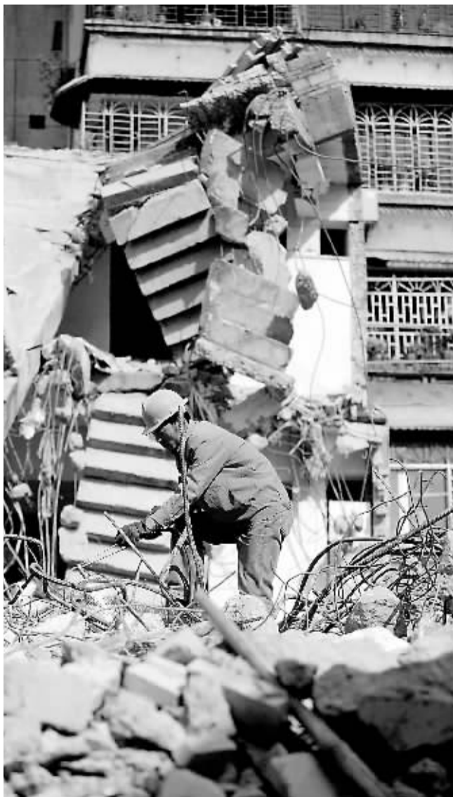
▲南华西旧城改造拆迁范围以内已用铁板全部围蔽,工人正在拆除危楼,大部分房屋已被拆平或仅剩框架。拆迁现场基本上看不到两层以上楼房,周围堆满拆卸下来的砖瓦和水泥钢筋。
